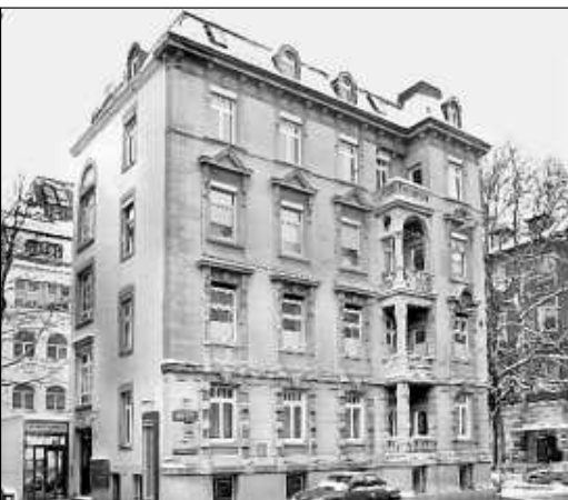
Aufwendig restauriert: Das Ulmer Gesundheitszentrum „fontevital“ in der Olgastraße 139.
